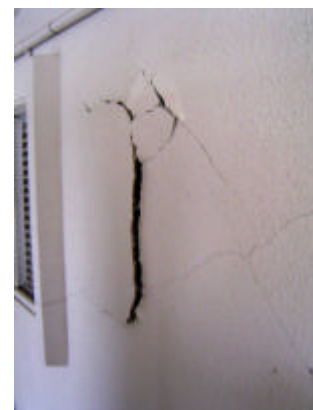
写真3 外壁のひび割れ
